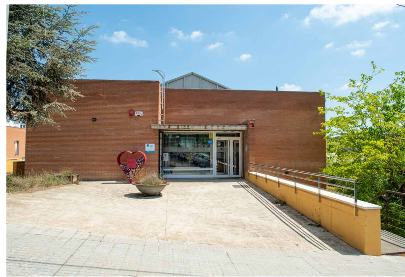
Consultori local La Torreta
